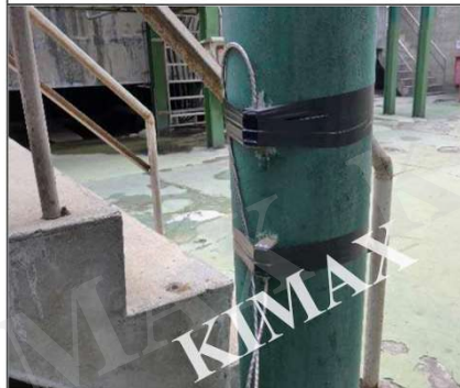
超音波流量計架設
